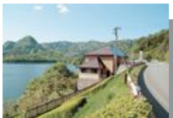
真野ダム駐車場
