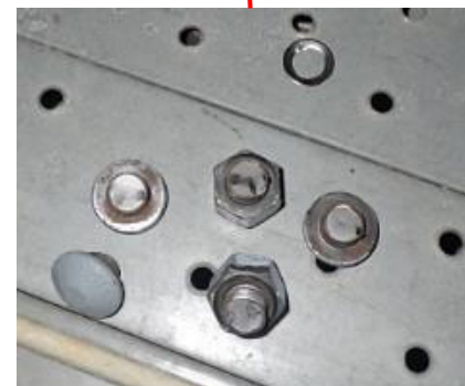
接合部のボルトが破断
