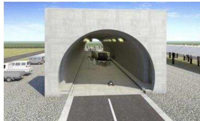
試験用トンネル：道路幅 6 m×50m
