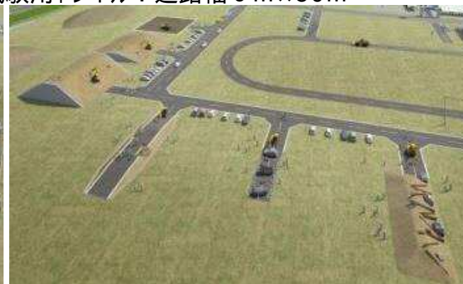
瓦礫・土砂崩落フィールド： 瓦礫散乱・土砂崩落道路、傾斜地、泥濘12
