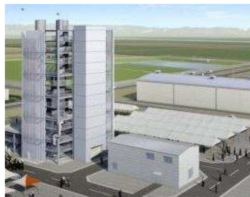
試験用プラント： 10m×12m×H30mの6階建て
