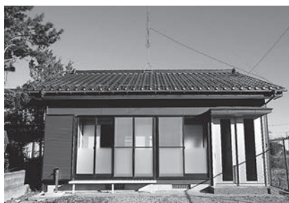
小高区等空き家リノベーションモデル 事業で市が改修を行った空き家
