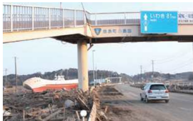
津波被害（鹿島区小島田地内）
