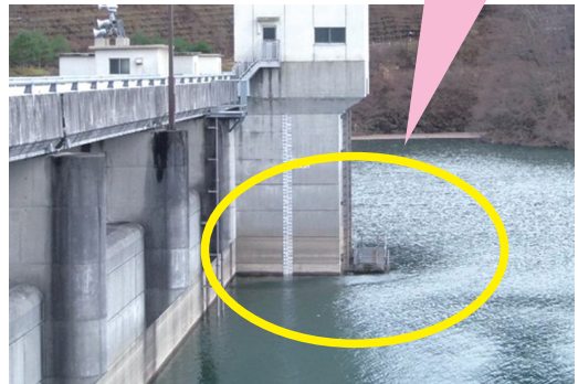
取水口は、水面下 1.5m で取水
