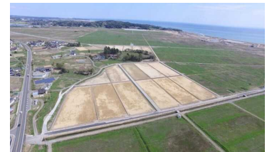
ほ場整備施工後
