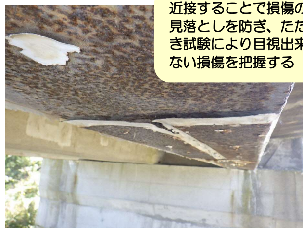
写真 2-4 近接目視点検のイメージ
