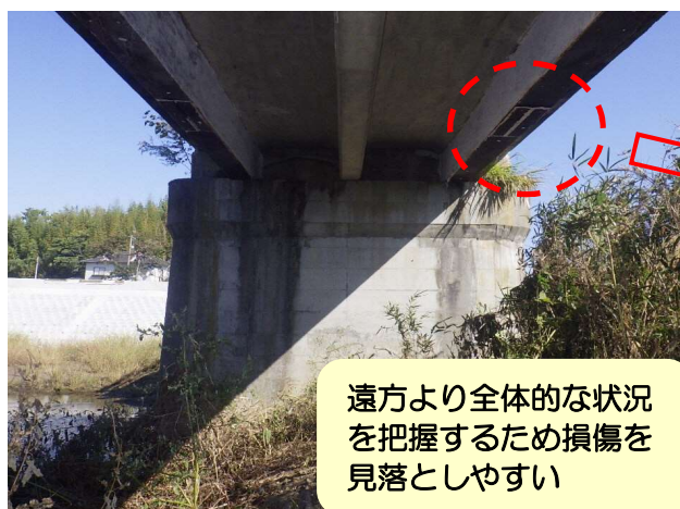
写真 2-3 遠方目視点検のイメージ
