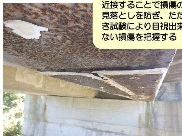
近接することで損傷の見落としを防ぎ、たたき試験により目視出来ない損傷を把握する
