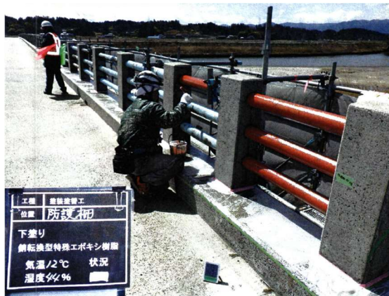
令和5年度 サビバリヤーでの修繕状況（下川原橋）
