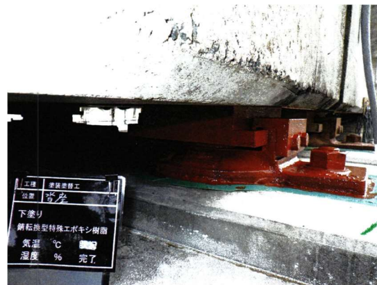
令和5年度 サビバリヤーでの修繕状況（下川原橋）
