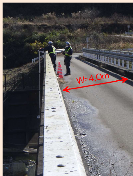
写真 6-3 ロボットカメラ【懸垂型】使用状況
