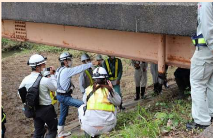
写真 5-1 令和2年11月20日 福島県橋梁点検講習会 清水橋（原町区大原地内）
