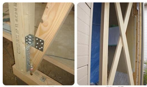
<耐震改修の実施例：筋交い補強>
