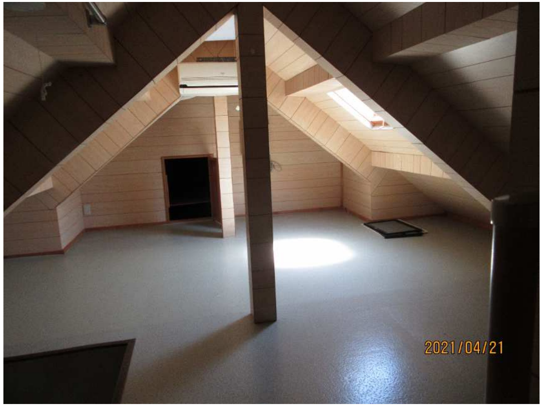
写真（2階小屋裏）
