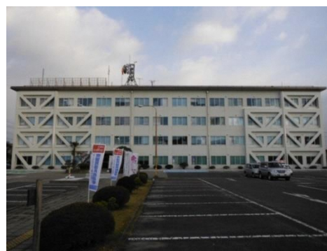
写真1-2 耐震改修工事（施工後）
