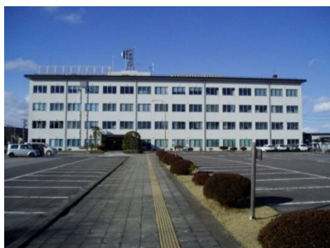
写真1-1 耐震改修工事（施工前）
