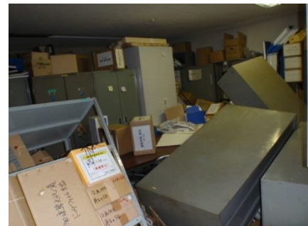
写真3 家具転倒被害状況
