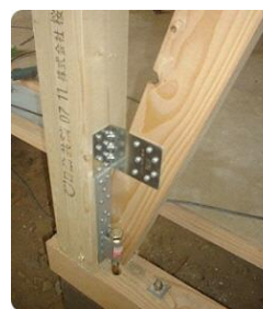
ホールダウン金物 設置
