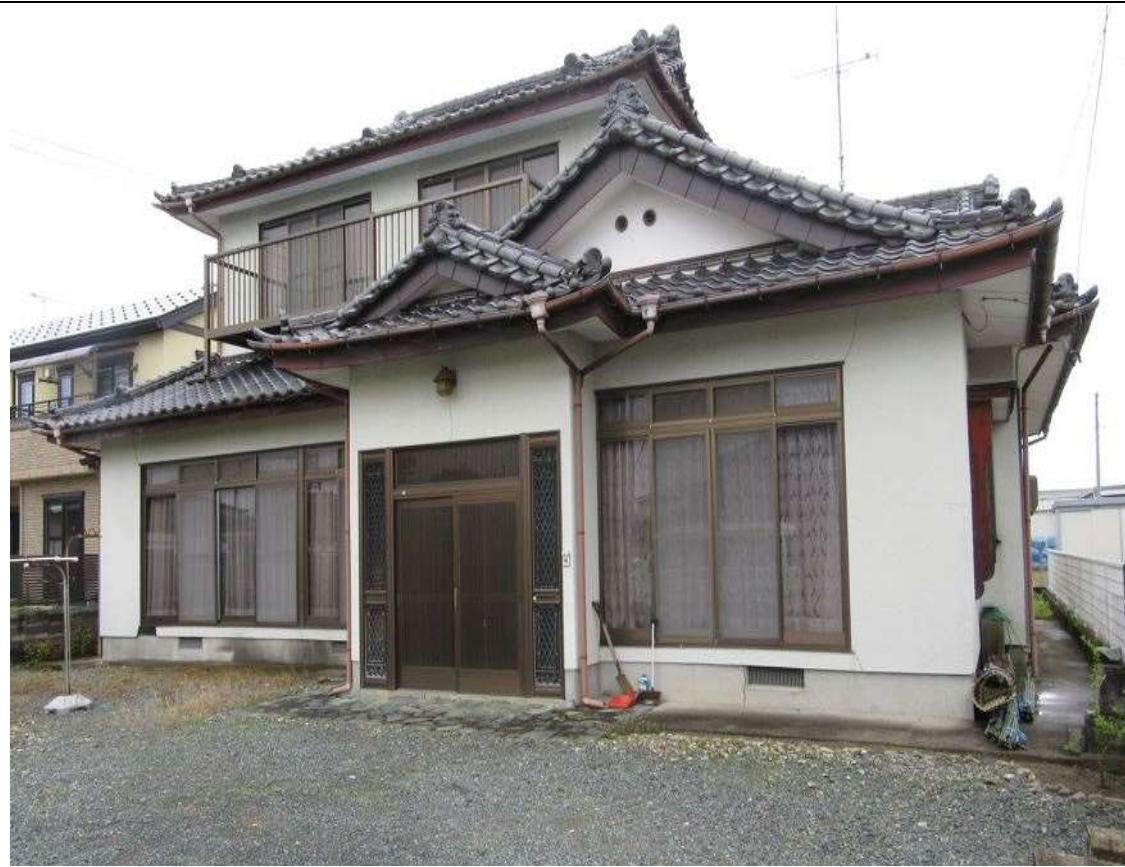
(12) 写真 (外観・内部の一部)
