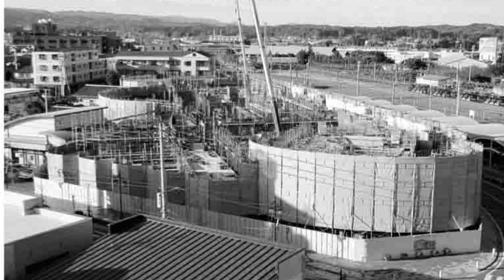
▲順調に進む新図書館建設工事
