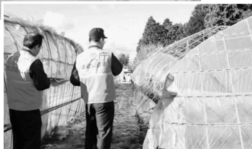
▲大雨による被害 (原町区三島町)
