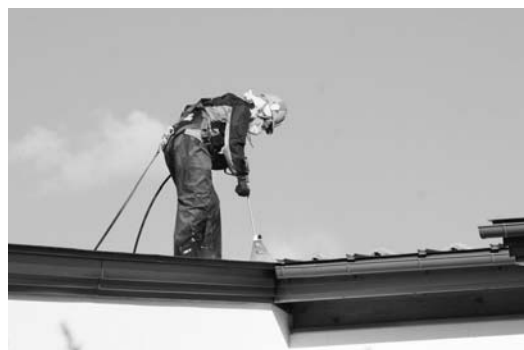
▶高圧洗浄機での屋根除染（押釜地区）
