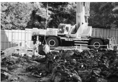
▲クレーンで積み上げられる大型土のう袋
