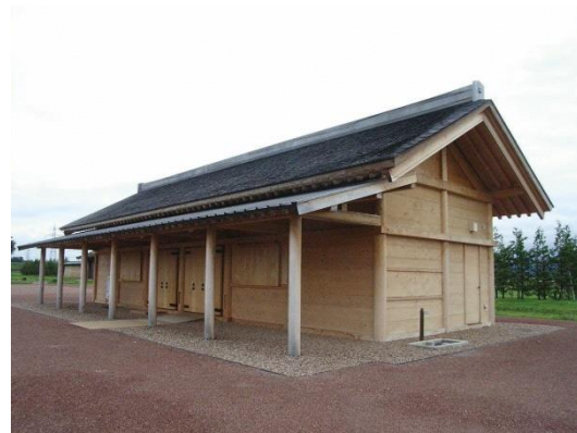
外観復元建物の例（志波城跡、岩手県盛岡市）
