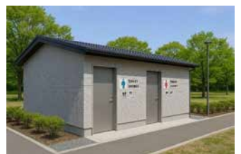
トイレ・シャワー
