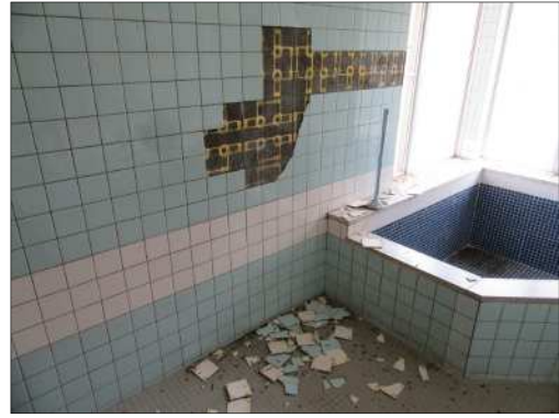
< 農業体験実習館風呂場タイル破損 >
