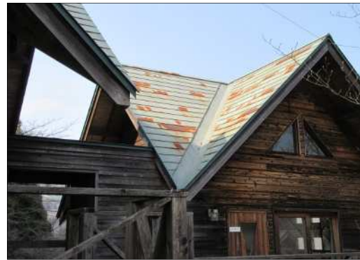
< バンガロー屋根錆付き >
