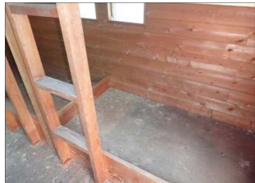
< バンガロー宿泊室汚損 >
