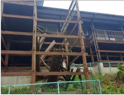
< 農業体験実習館デッキ破損 >
