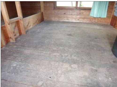
< バンガロー宿泊室汚損 >
