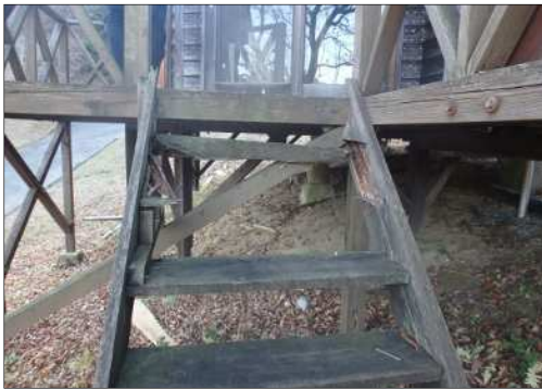
< バンガロー階段破損 >
