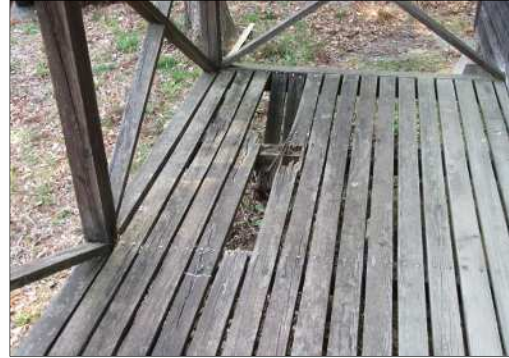
< バンガローテラス破損 >
