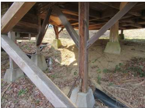
< バンガロー構造体腐食 >
