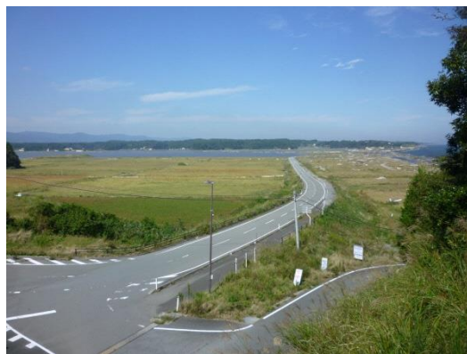
⑦浦尻地区から望む旧井田川浦
