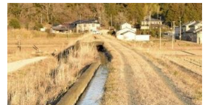
七千石用水路（鹿島区）
