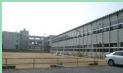
▶ 鹿島区の仮設校舎
