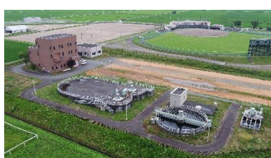
【鹿島浄化センター】
