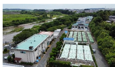
【原町第一下水処理場】
