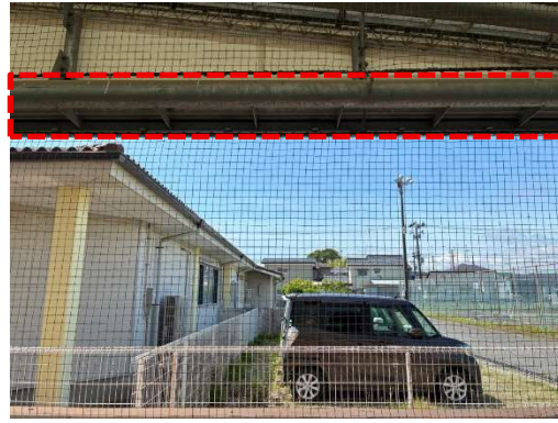
図－２ 作業箇所（隙間）
