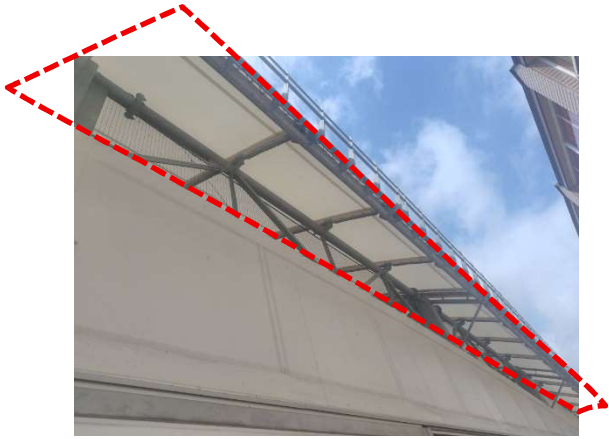
図－１ 作業箇所（軒先）
