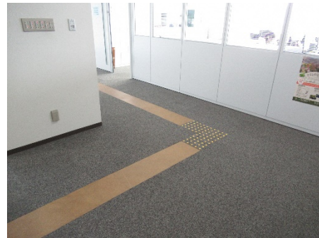
屋内誘導路（福島市役所）
