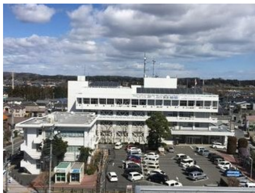
本庁舎・西庁舎・駐車場の状況
