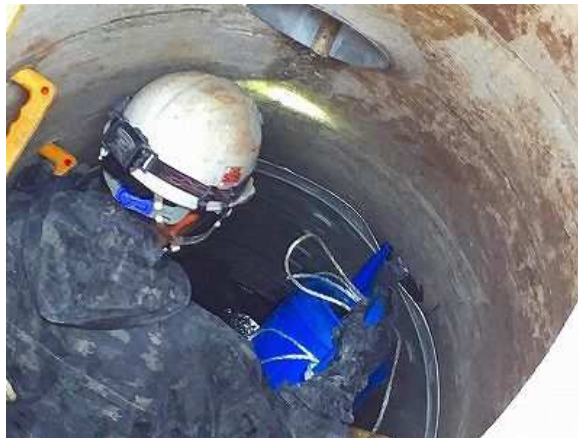
写真－４ 充てん状況
