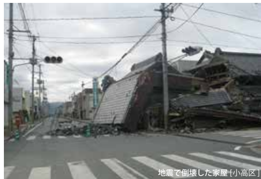
地震で倒壊した家屋【小高区】
