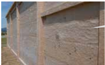
図16 掘立柱塀の板壁
