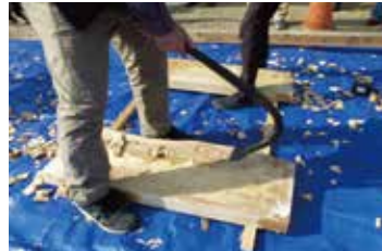
図10 チョウナによる製材の様子
