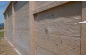
図16 掘立柱塀の板壁
