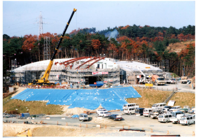
建設中の博物館 平成6年(1994)
