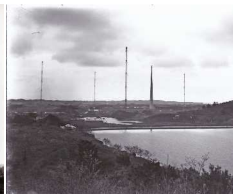
▲無線塔と副柱（昭和初期） 主塔と副柱にクモの巣のように空中線を張りめぐらせ、巨大なアンテナを形成しました。
