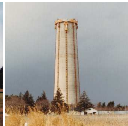
▲解体中の無線塔 (昭和 57 年)
