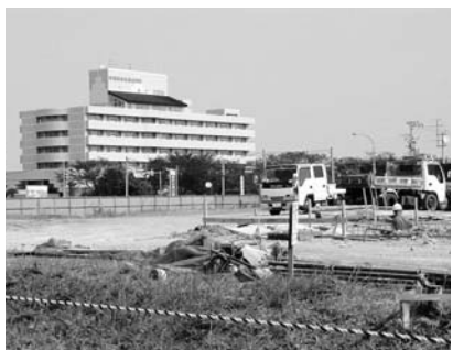
道の駅建設工事
