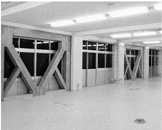
▲耐震補強工事（原町一中）
