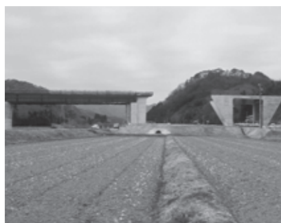
▲高速道路建設状況
