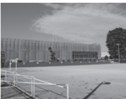
▲原一小耐震工事
