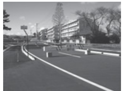
▲通行止めになっている道の駅西口道路
