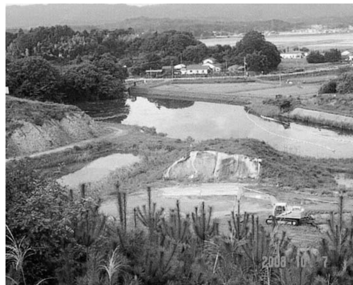
▲産廃処分場建設予定地（大壘地区）
