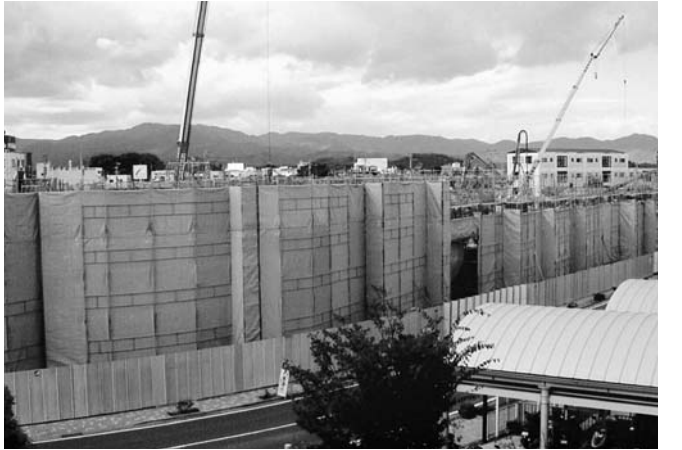
▲工事が進む図書館建設
