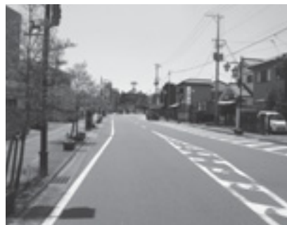
都市計画道路環状1号線（原ノ町駅前付近）
