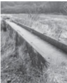
小高江用水路の川房箱樋
