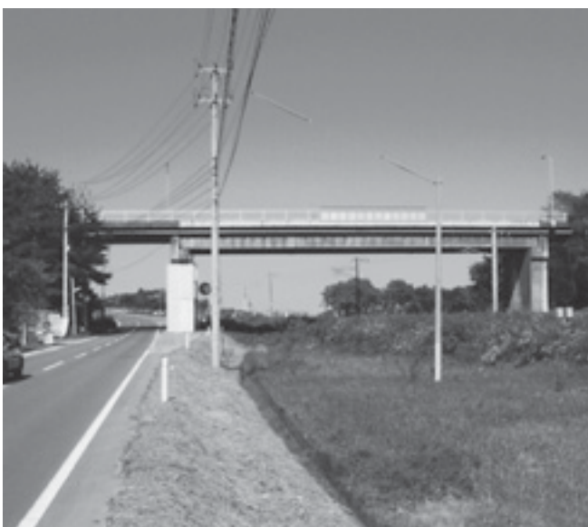
耐震改修中の橋（原町区北原）
