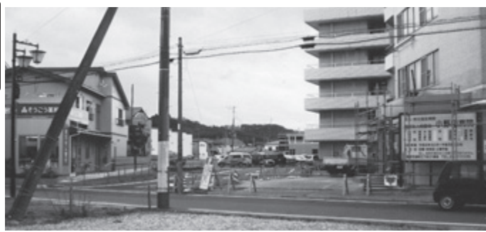
建設中の環状1号線
