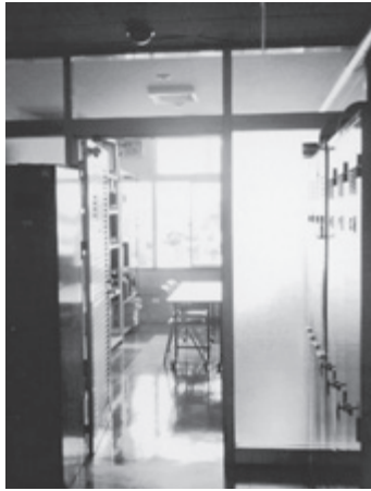
廃止された喫煙室
