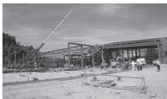
小高南工業団地で建設中の藤倉ゴム工業(株)新工場
