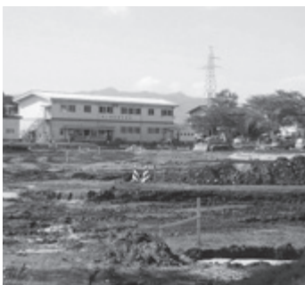
改修工事中の陸上競技場
