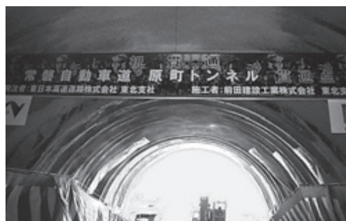
貫通した常磐自動車道原町トンネル
