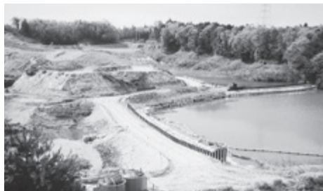
大甕産廃処分場建設工事現場
