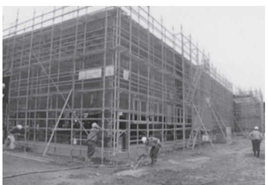
藤倉ゴム工業(株)工場建設のようす
