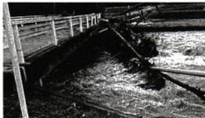
大きくえぐられた道路と橋の損壊状況 (原町区高倉地内)
