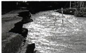
大きくえぐられた道路と橋の損壊状況 (原町区高倉地内)
